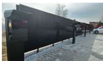
Der Solarzaun liefert Strom für die Ladeinfrastruktur.
